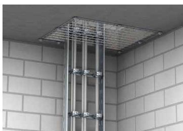
Travamento contra quedas durante montagens em tetos, utilizando telas de aço.
